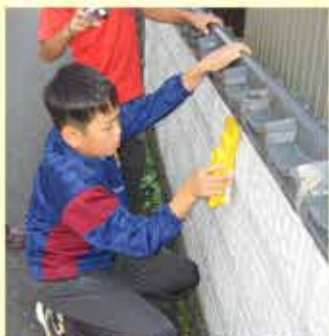
(塀の中の鉄筋を確認中)
